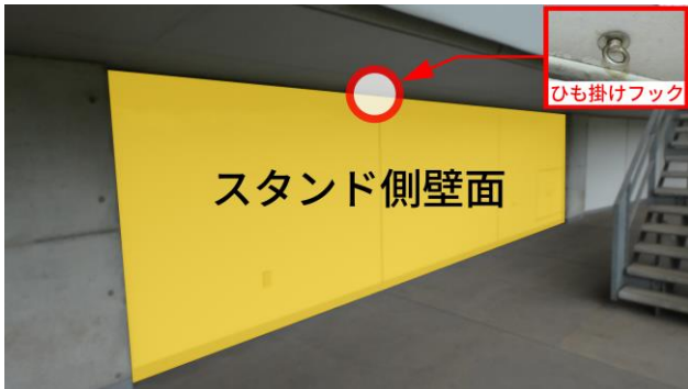
下層階通路 スタンド側壁面
