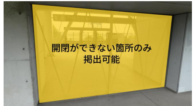
下層階通路 スタンド側フェンス
