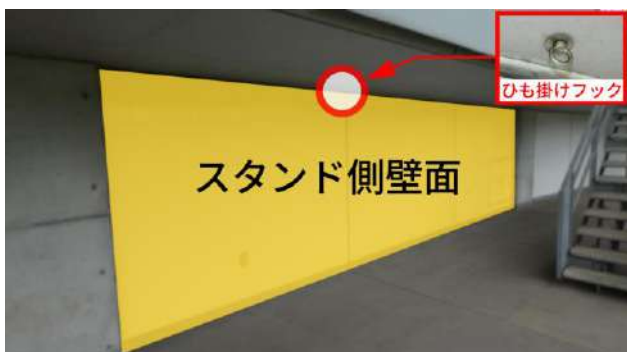
下層階通路 スタンド側壁面
