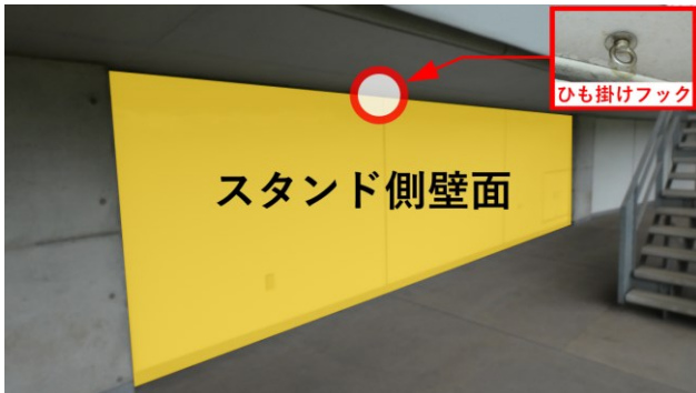
下層階通路 スタンド側壁面
