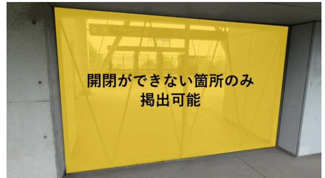
下層階通路 スタンド側フェンス
